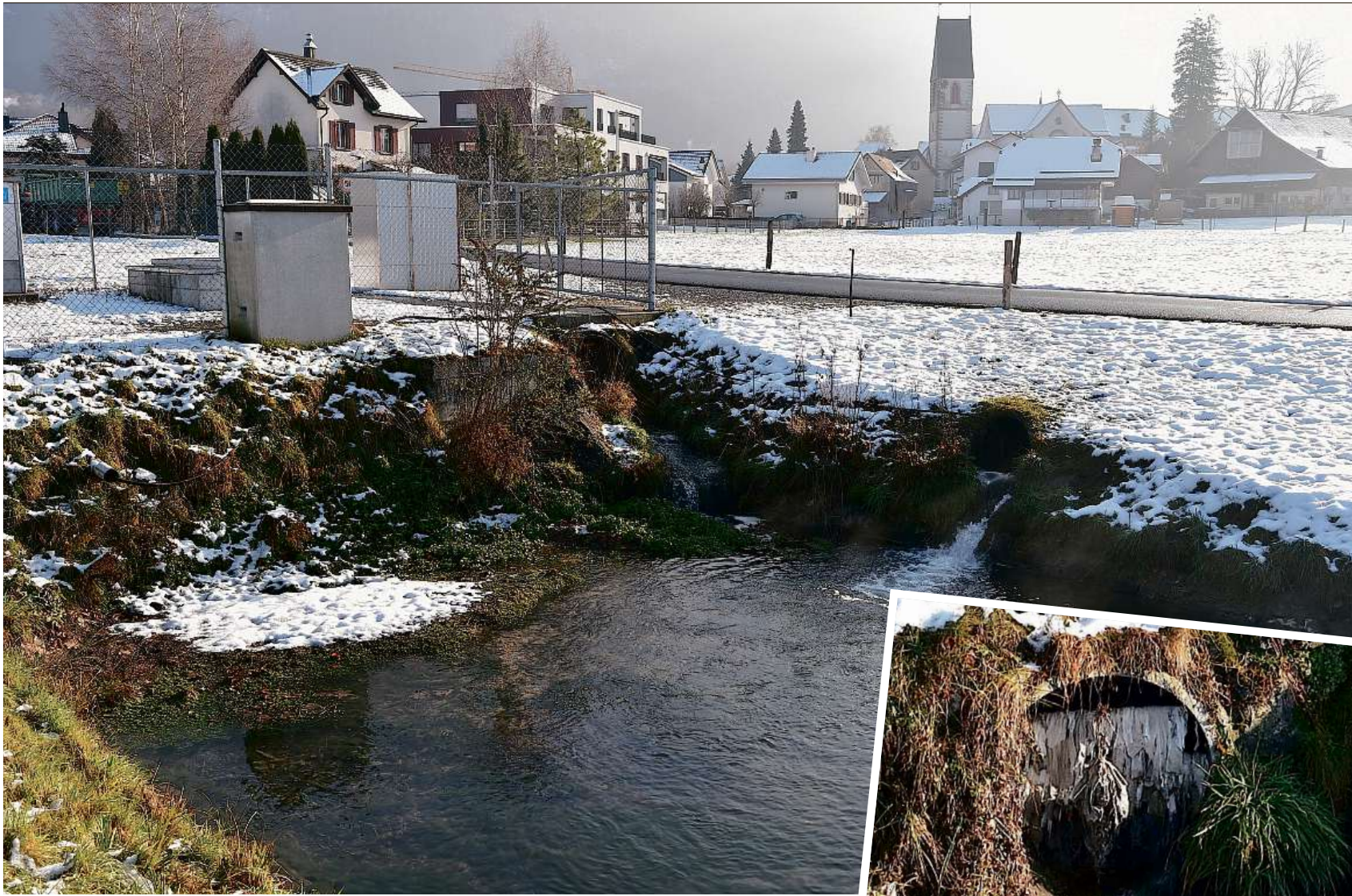
Ungelöst: Im Schänner Chrüppelbach schwimmen laut Fischern immer noch Tampons, Binden und WC-Papier.
